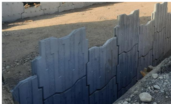
1-rasm. Ko'priklar yaqinlashuv ko'tarmasining taklif etilayotgan tirkak devorlar ko'rinishi
