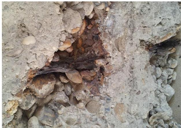
**Рисунок 10. Вид коррозии арматуры и выкала бетона**
